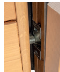
2 renforts anti-poussée ouvrant/dormant
